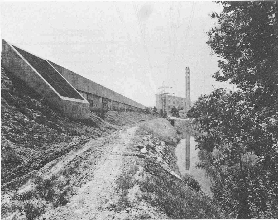
Westseite mit Brüelbach, im Hintergrund das Heizkraftwerk
