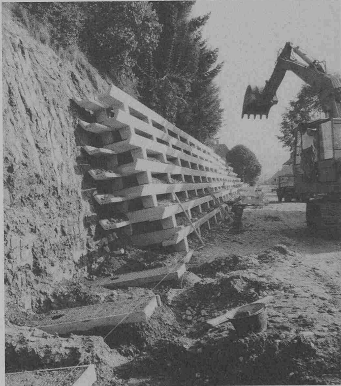
Bau einer Stützmauer an der Staatsstrasse Walkringen (BE)
