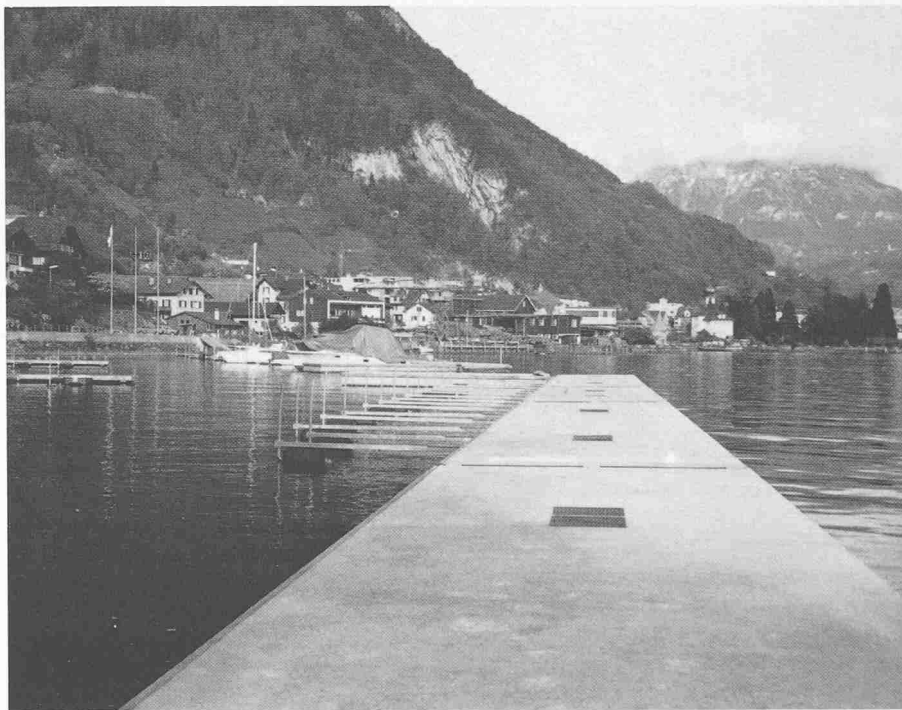
Hafenanlage in Gersau, Mole 4 m breit
