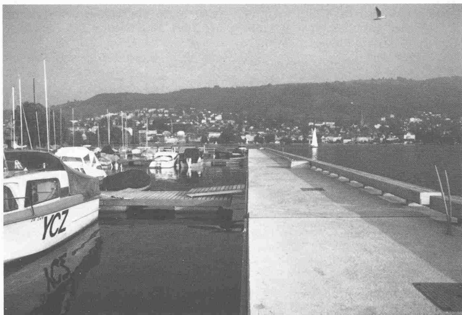
Hafenanlage in Zug, Mole 4 m breit
