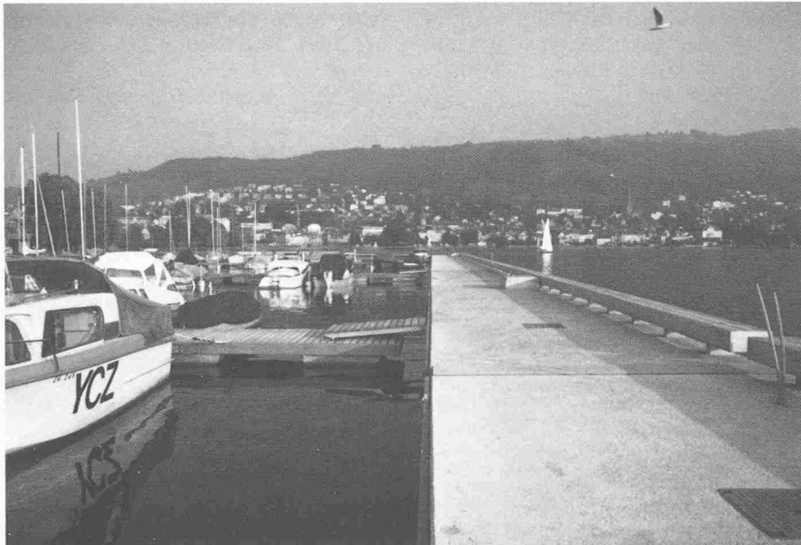
Hafenanlage in Zug, Mole 4 m breit
