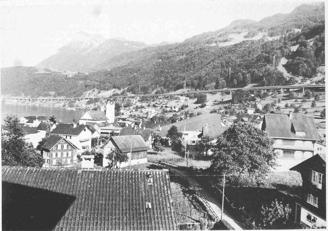
Auf einer Länge von 3148 Metern, gestützt auf 58 Pfeiler, zieht sich der Viadukt wie ein schmales Band über den topographisch und geologisch komplexen Hang zwischen Beckenried und dem Nordportal des Seelisbergtunnels
