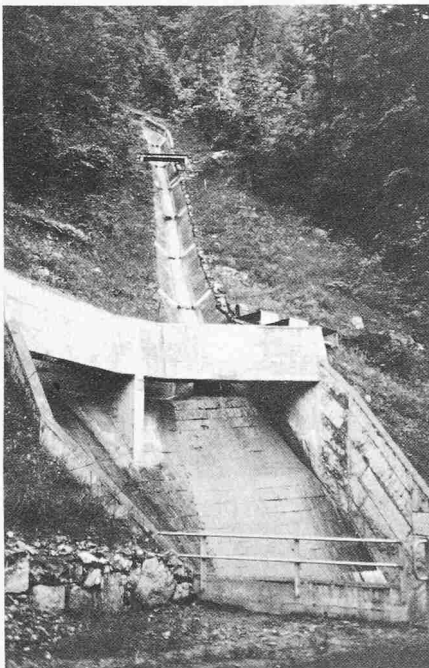
Bild 9. Chellbach. Ortbetongerinne mit hundertprozentigem Gefälle und Kiessammler
