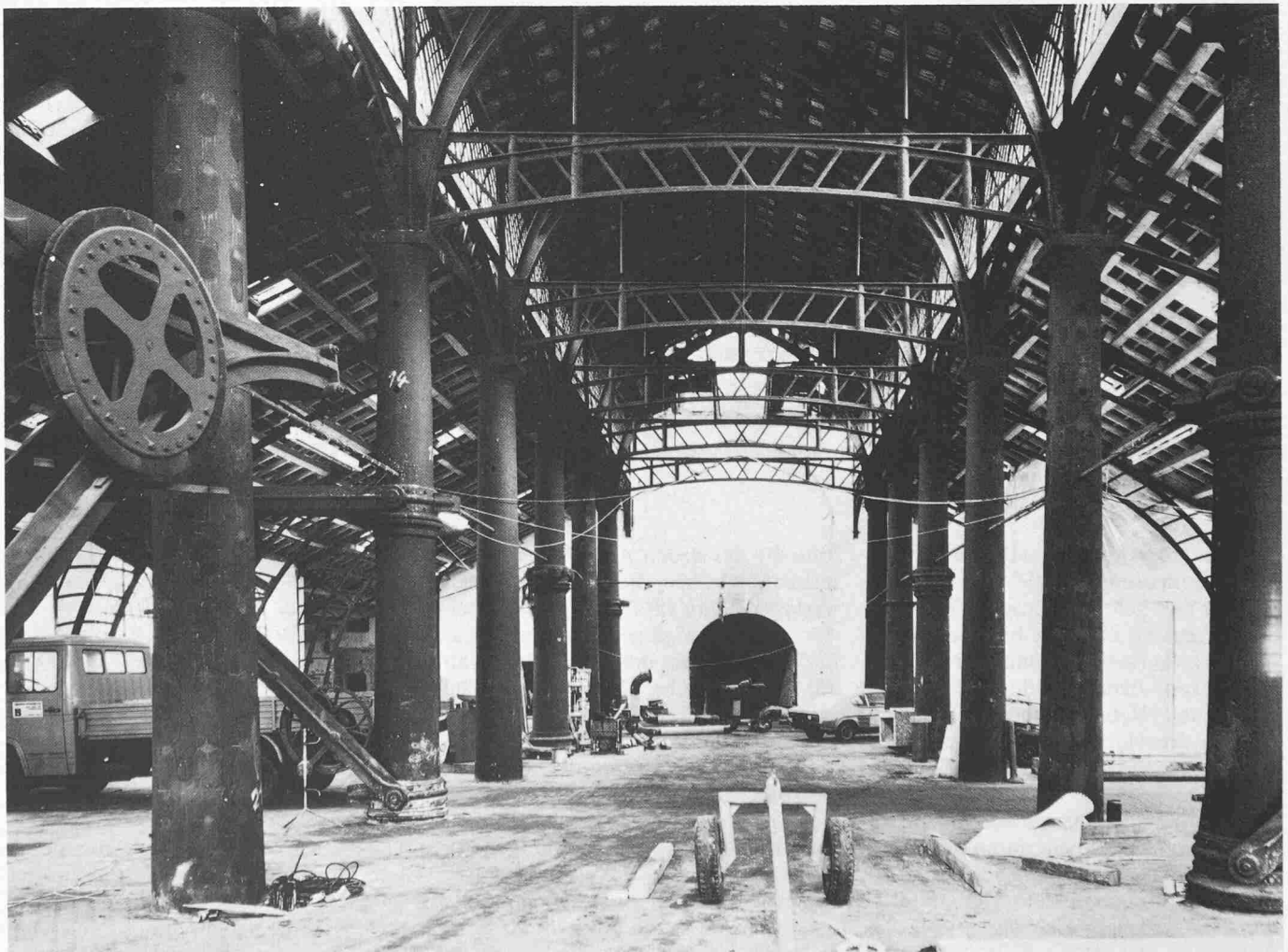
Inneres der Giesshalle, Zustand im Februar 1979
