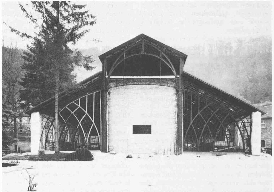
Stirnseite der Giesshalle, Zustand 1979
