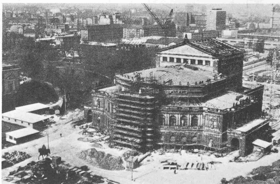
Die Baustelle im Frühjahr 1979. Eindeckungsarbeiten am Dach des Zuschauerraumes, die Bühnenhausbinde während der Rekonstruktion
