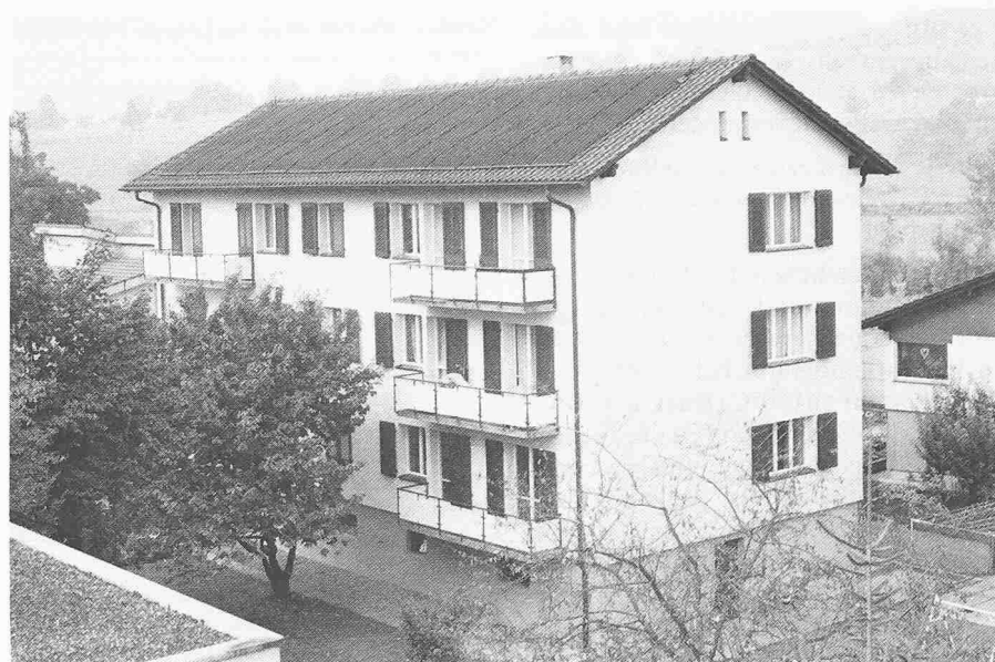
Die Projektliegenschaft in Baar (Kt. Zug)
