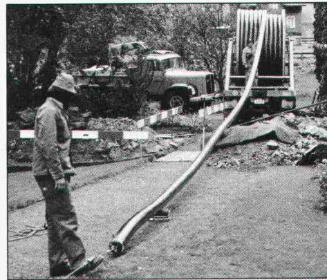
10.04 Die Verlegung der FLEXWELL-Leitung beginnt...
