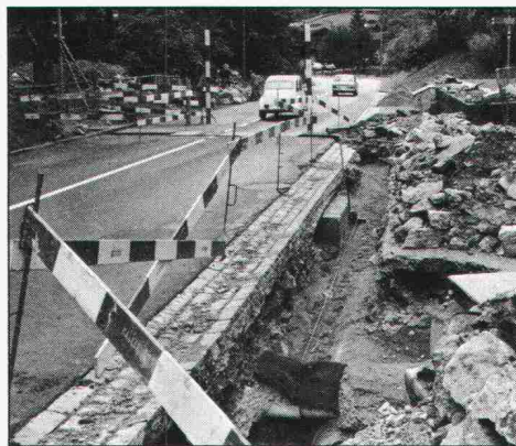
09.57 Das Zugseil ist in den Graben eingelegt...
