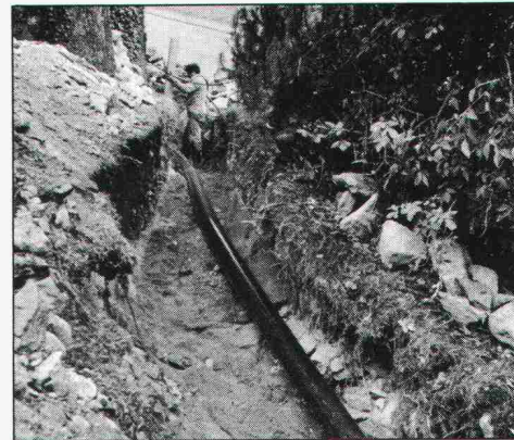
10.45 Die erste Länge ist verlegt...
