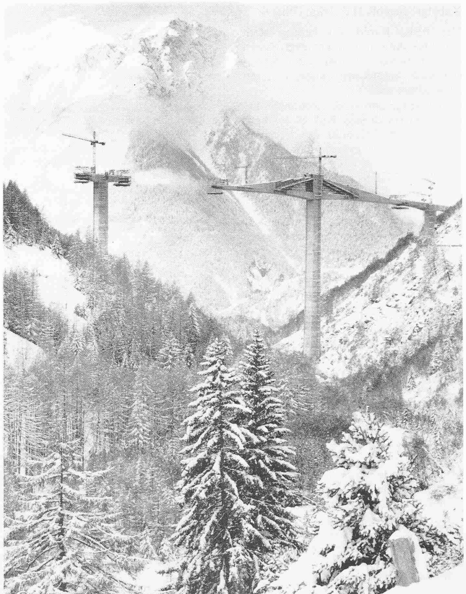
Bild 1. Bauzustand der Ganterbrücke während der Versuche am 16. November 1979
