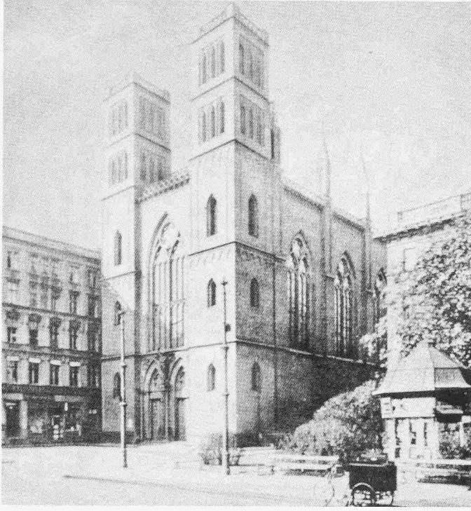
Die Friedrich-Werdersche Kirche (1824–1830), Ansicht von Südosten
