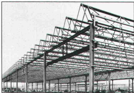
Metallstruktur eines Fabrikgebäudes mit Mini-Sheddach
