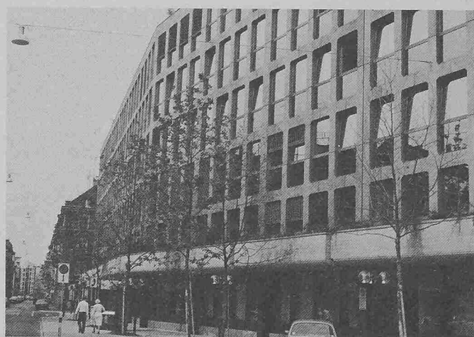
Verwaltungsgebäude der Kreistelefondirektion Zürich. Fassade aus Aluminium-Herdgussplatten
