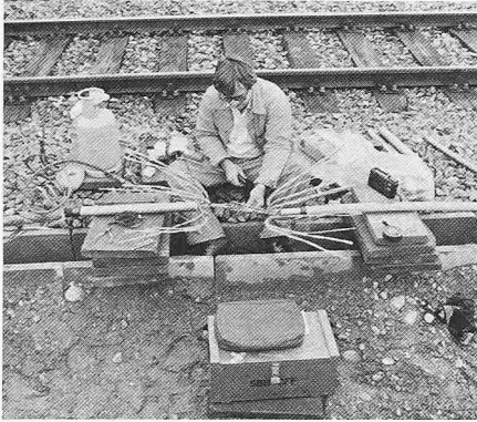
Bild 10. Kabelmonteur bei der Spleissarbeit
