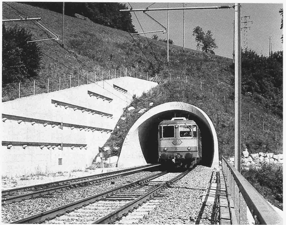
Bild 5. Südportal mit Bohrfahlwand
