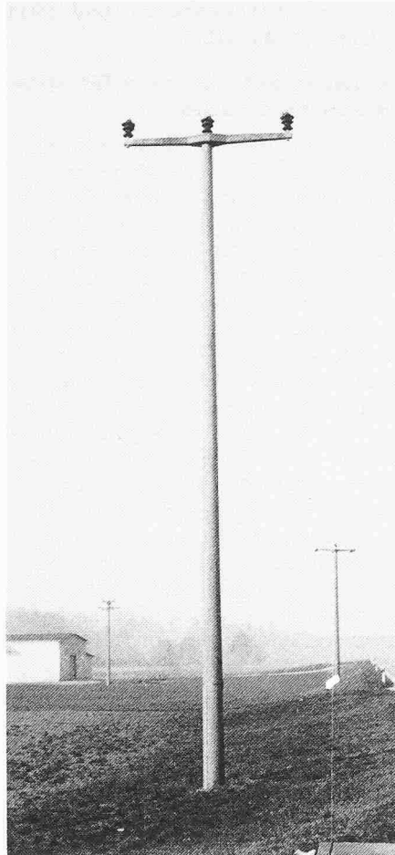
20-kV-Einfachleitung (Tragmast, L = 10-12 m)
