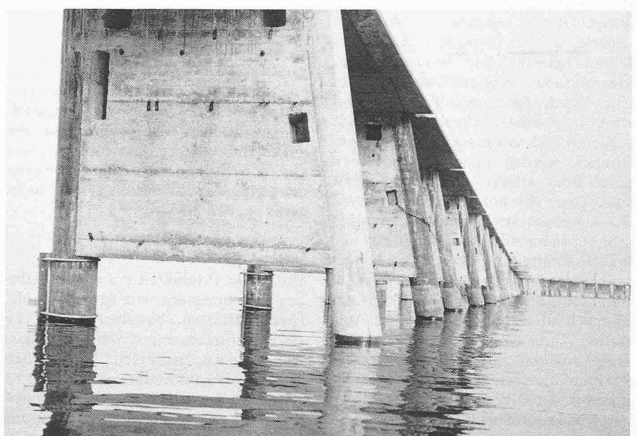
Pfähle für die Hafemole Arbon
