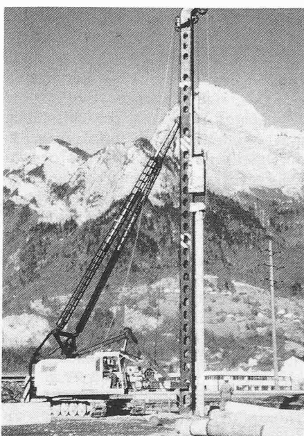
Pfähle für Brückenfundation (Sargans/SG)
