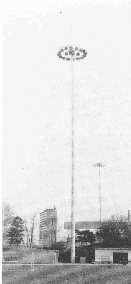
Beispiel eines Schleuderbetonmastes: Beleuchtungsmast (Länge: bis 45 m)
