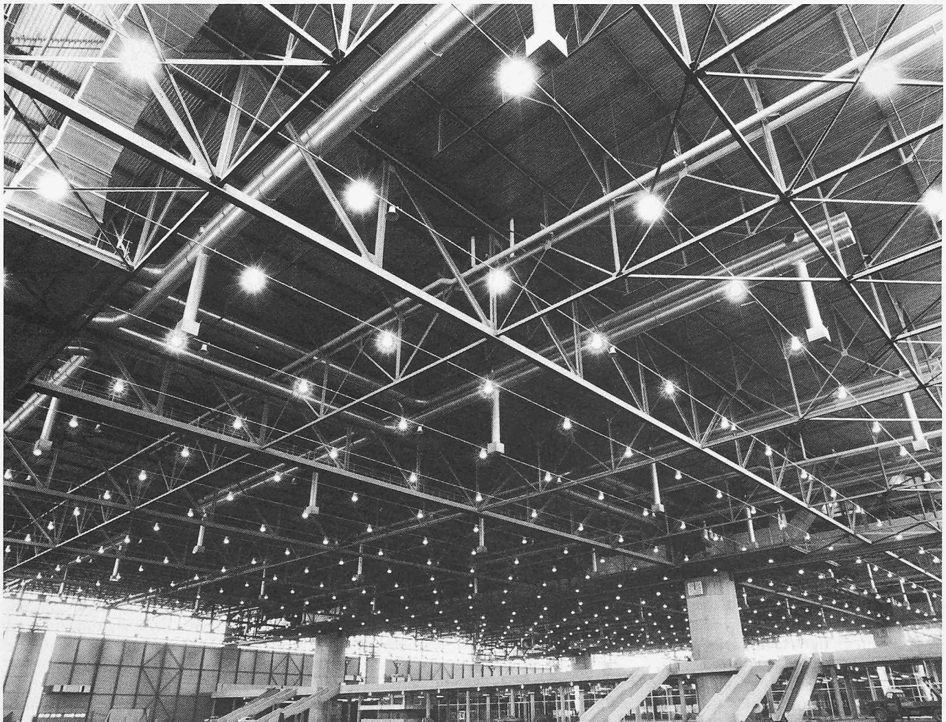
Innenaufnahme der Halle C mit Blick Richtung Halle B und A. Freie Höhe: 18 bzw. 12 m
