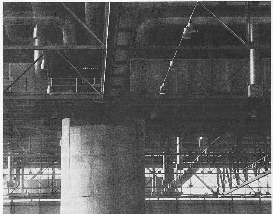
Fertige Stahlkonstruktion im Bereich eines Auflagerturms
