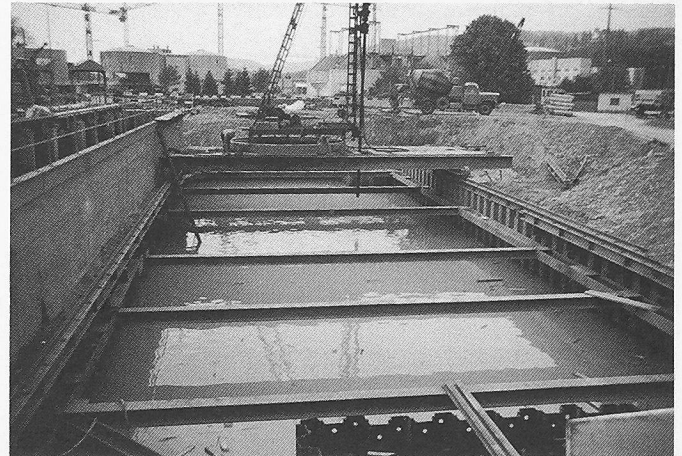
Bild 3. In bestimmten Arbeitsetappen werden Bauteile geflutet
