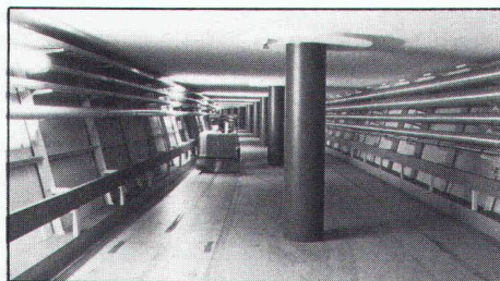
Transportkanal für Handgepäck im Flughafenbahnhof Kloten. VERMIPAN-Platten, 40 mm dick. Totale Wandlänge ca. 1200 Meter.
