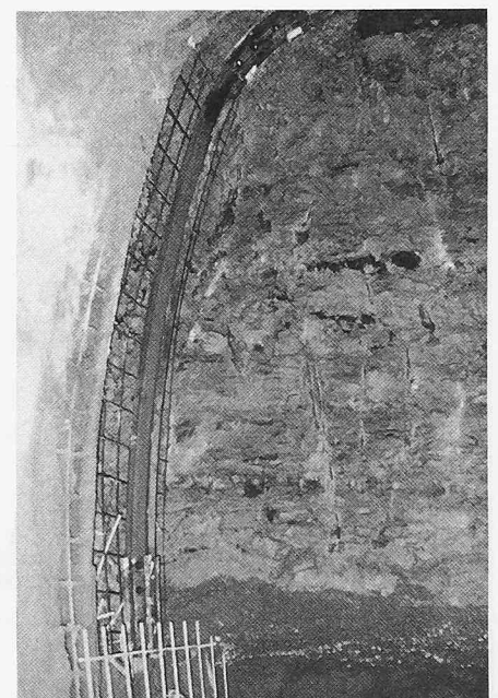
Bild 6. Tunnelausbau in NATM mit Tunnelbogen aus Stahl zur Stützung der Kalotte und mit Spritzbetonauskleidung bewehrt mit Betonstahlmatten
