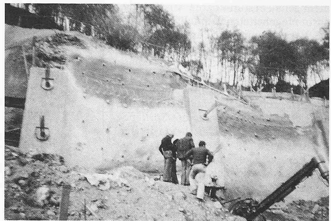
Bild 8. Sicherung der Böschung von Bild 7 mit verankerten Lisenen mit Spritzbetonschale dazwischen
