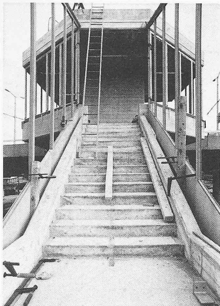
Bild 5. Der Treppenaufgang im Bauzustand April 1982. Die seitliche Einfassung ist bereits montiert
