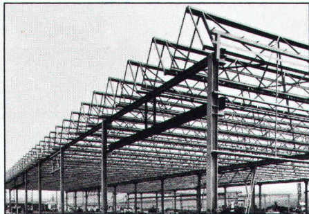
Metallstruktur eines Fabrikgebäudes mit Mini-Sheddach
