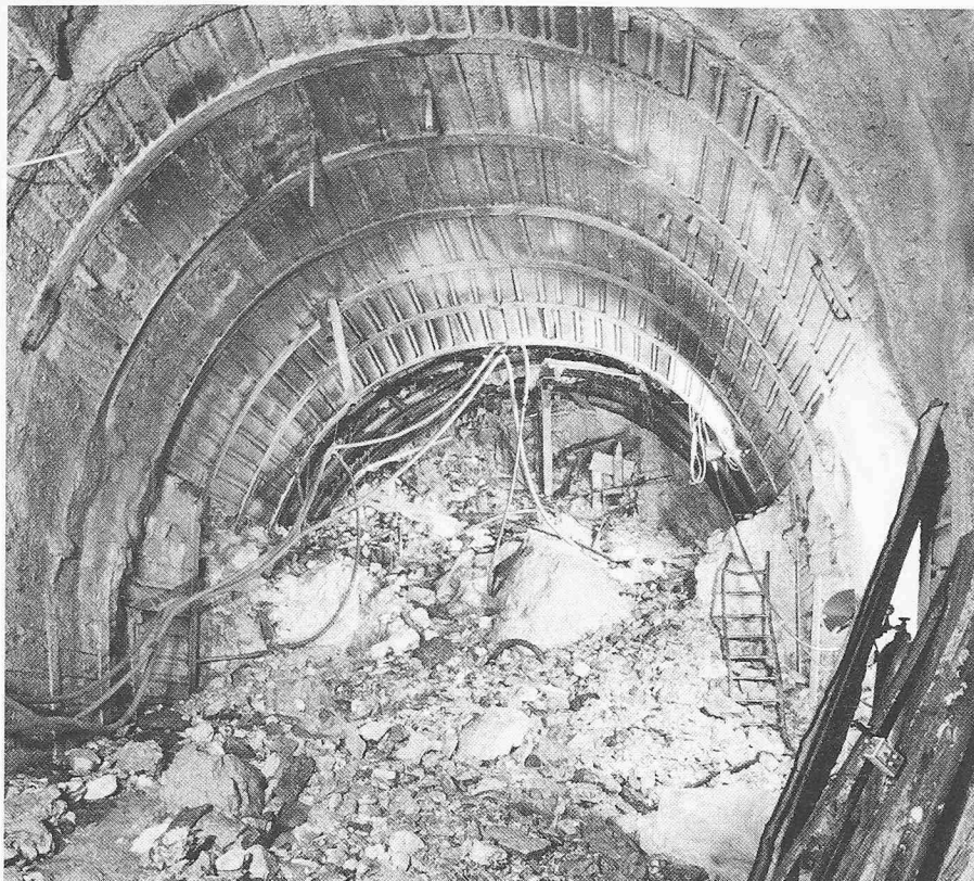
Bild 7 (oben). Hufeisenprofil. Deformationen im Stahleinbau bei Tm 8500
