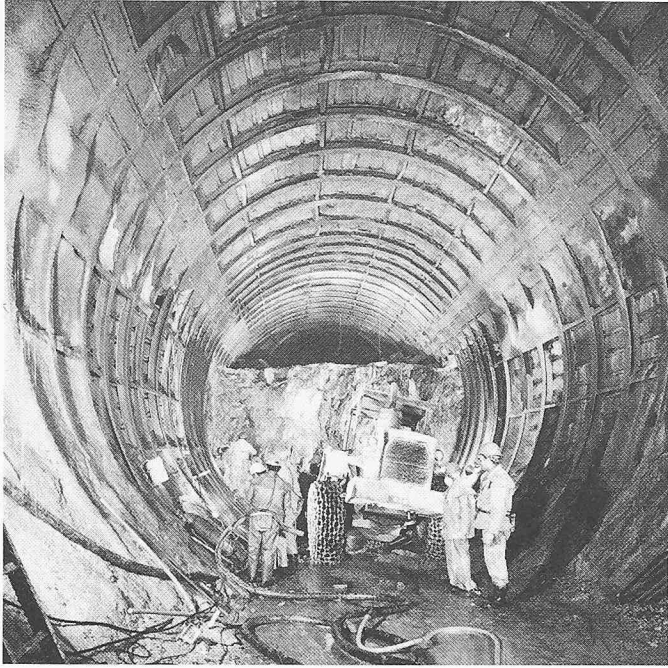
Bild 10. Strossenabbau im Kreisprofil
