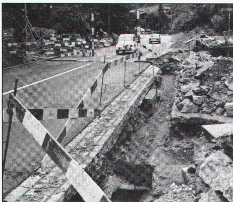
09.57 Das Zugseil ist in den Graben eingelegt...
