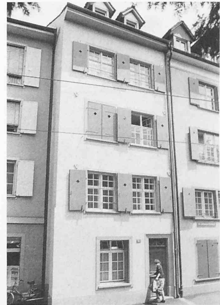
Strassenseite nach der Sanierung
