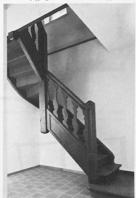
Im Haus Pfeffergässlein 10 erhaltene Treppe
