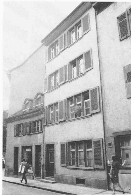
Rheingasse 65+67, Strassenfassade, vor der Sanierung
