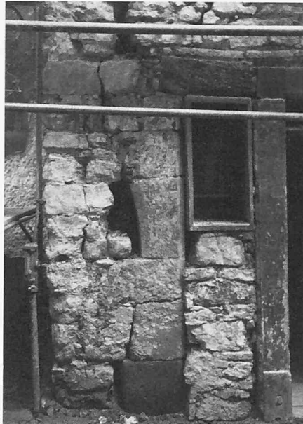
Sanierung des Eckverbandes, Detailansicht
