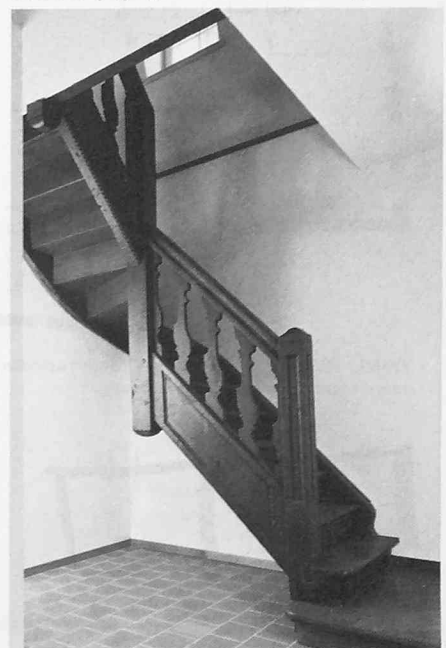
Im Haus Pfeffergässlein 10 erhaltene Treppe
