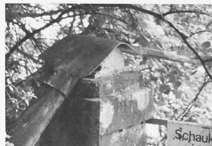
Detail eines Pylonsattels mit gusseisernem Zylinder
