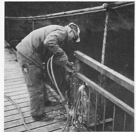
Abbruch des alten Steges
