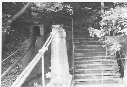
An beiden Brückenden (hier die Damsauseite) laufen die Hauptkabel über gusseiserne Zylinder, die auf den Pylonen angebracht sind
