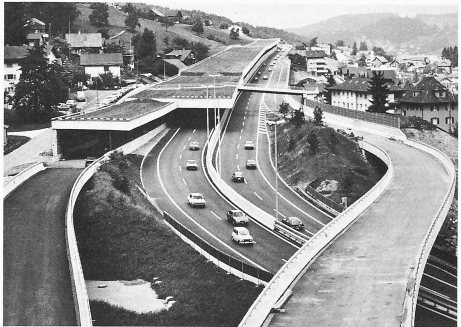
Bild 12. Anschluss N2/N8. Brücken (Baulos 42), Trasse (Baulos 15) und Lärmschutzgalerie (Baulos 62). Blick vom Loppertunnel in Richtung Norden
