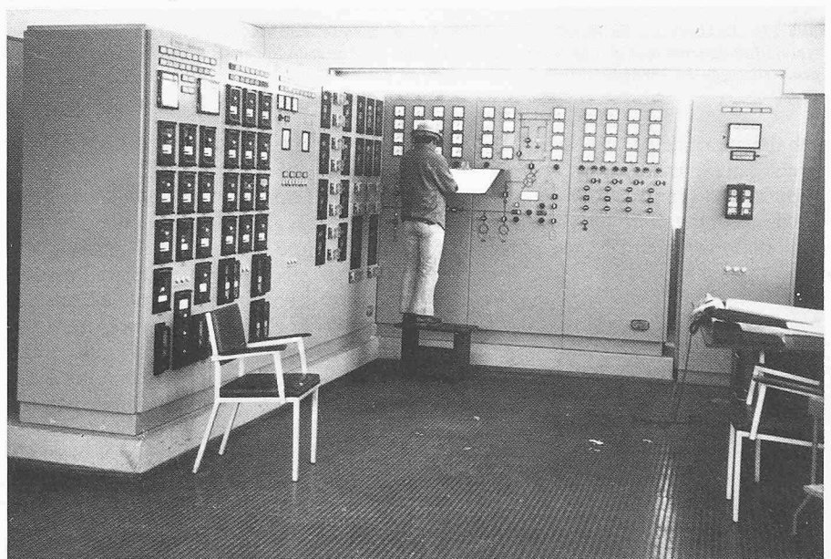
Bild 20. Zu hoch angeordnete Instrumente
