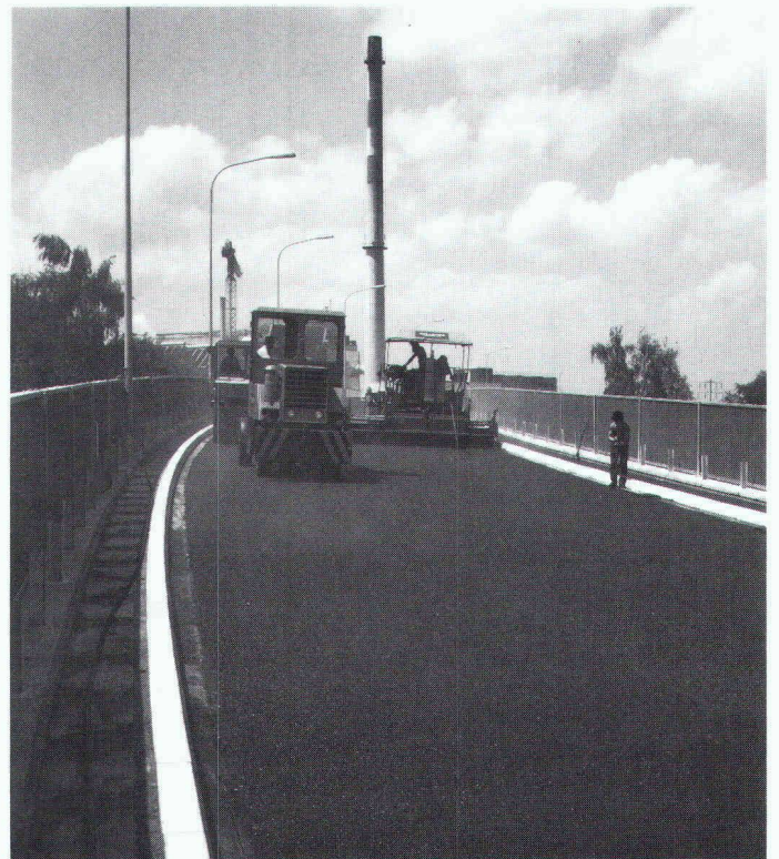
Einbau der Schutzausgleichs- und Verschleiss-Schichten
