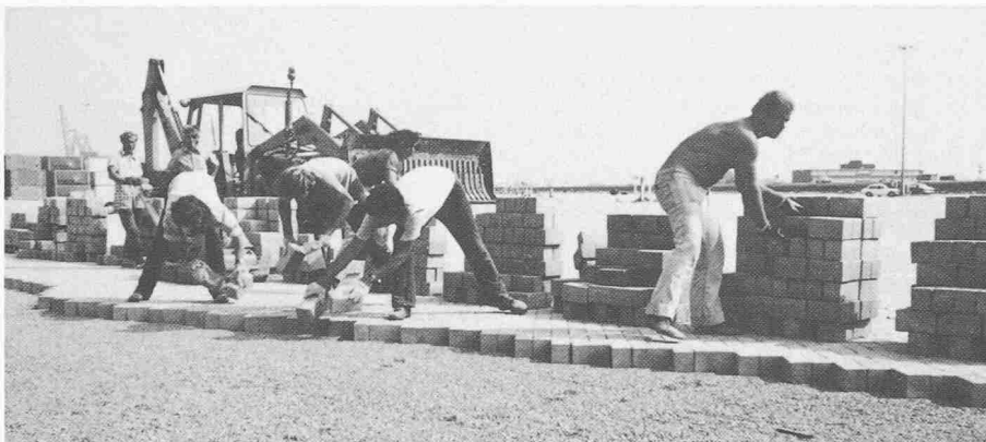
Bild 2. Betonpflastersteine (20/10/12 cm) im trockenen Splittbett zur Befestigung schwerbelasteter Hafensflächen (Container-Terminal) verlegt
