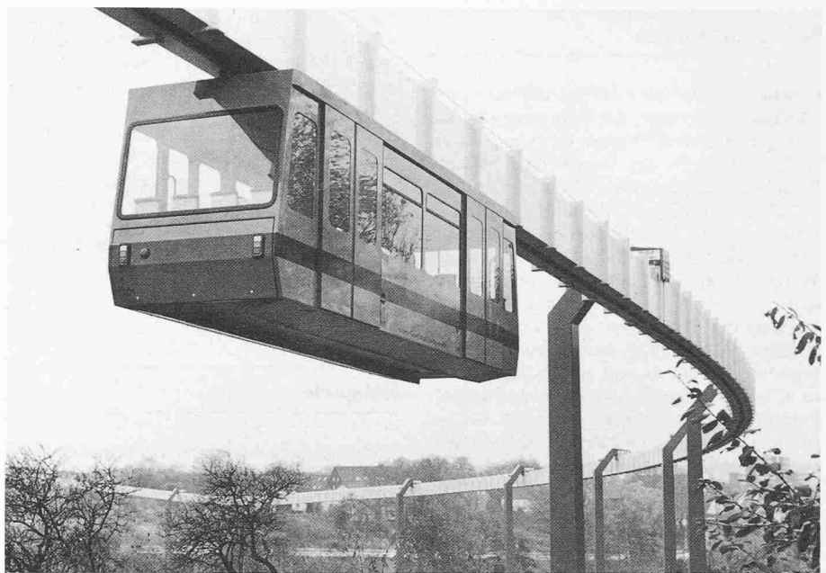
Aufgehängt an Stahlstützen, zieht die eingleisige Fahrbahn über meist freies Gelände hinweg
