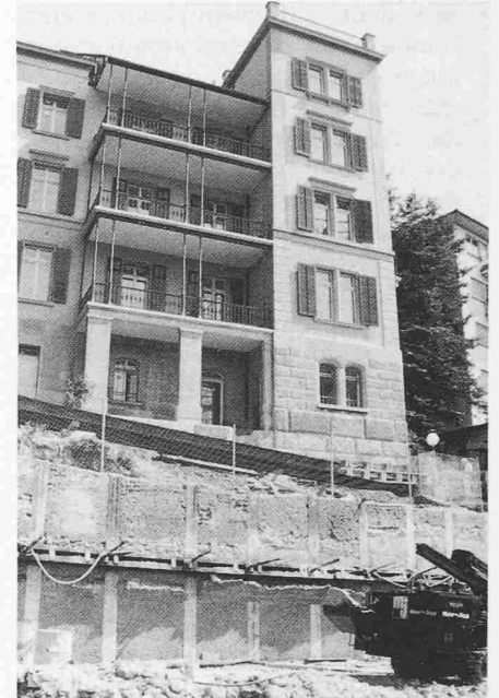
Bild 10. Ansicht der Rühlwand während der ersten Aushubetappe
