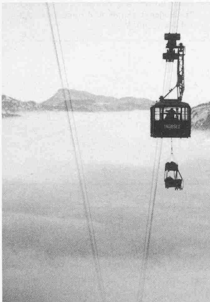
Bild 11. Antransport des Spannmaterials mit der Seilbahnkabine
