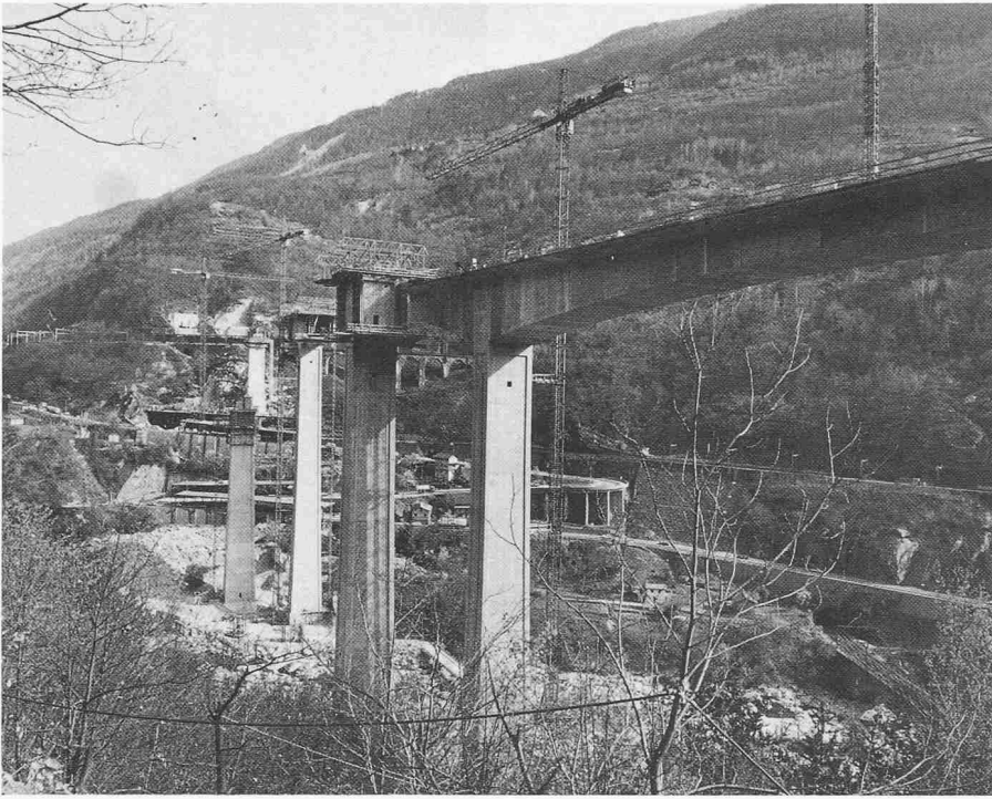
Baustelle Viadotto della Biaschina
