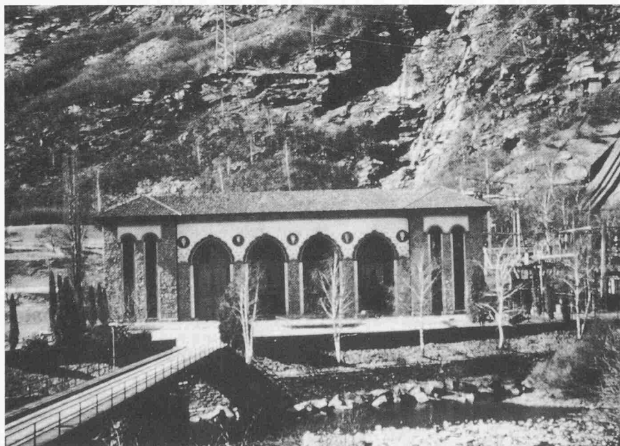
Bild 1. Centrale del Piottino, Lavorgo
