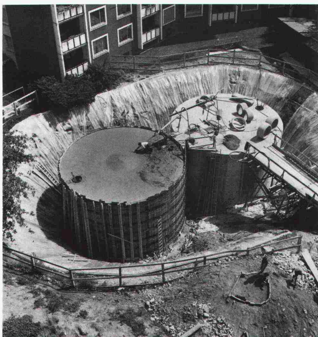
Überbauung Heiligfeld, Zürich: Diese beiden Heizöltanks aus Beton fassen zusammen 500 000 Liter Heizöl. Nach Fertigstellung sind sie unsichtbar im Erdreich.
