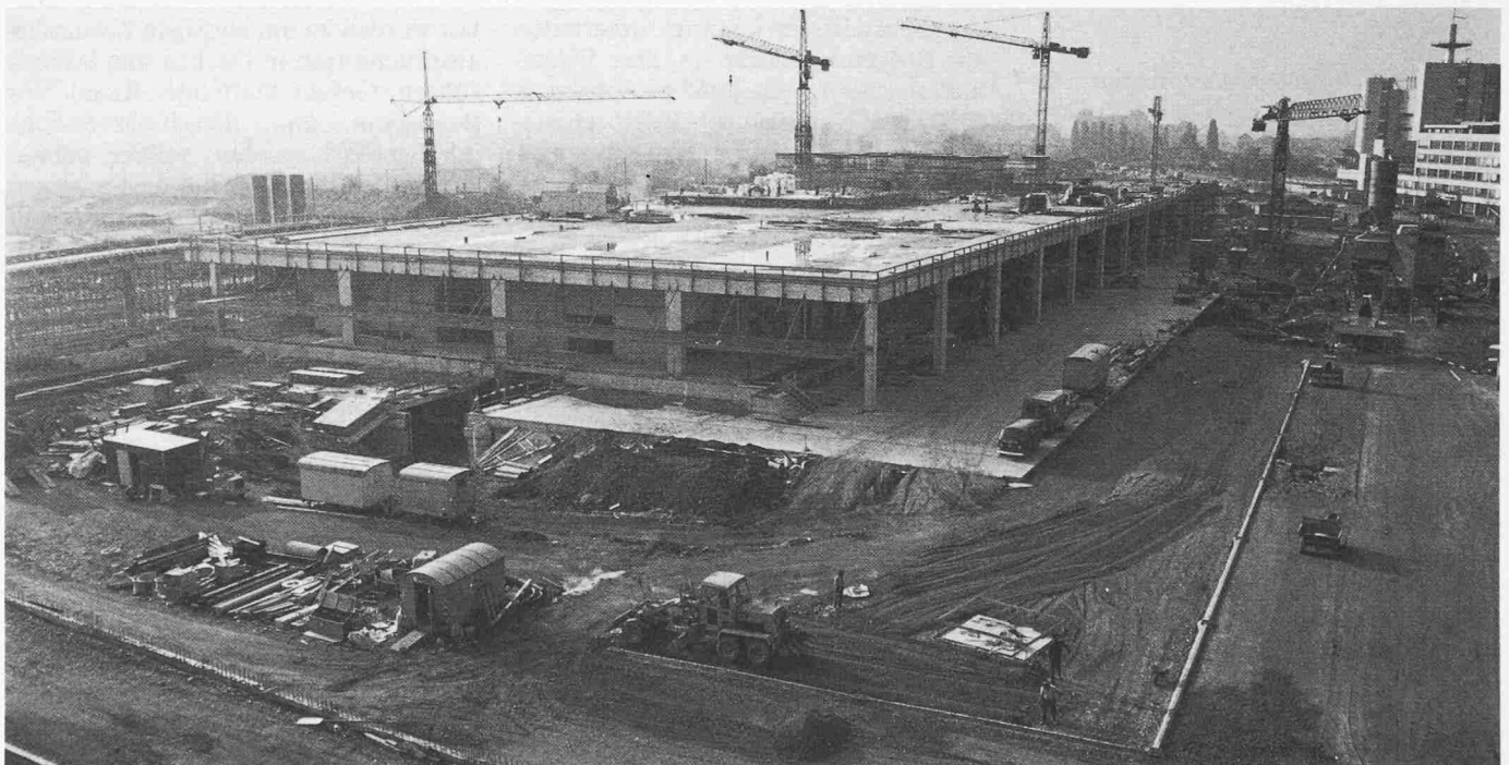
Bild 14. Blick auf die Baustelle vom Parkdeck der Migros Herdern im Osten des Marktareals. Importeuremarkt mit der Dachebene für die spätere Zusatznutzung
