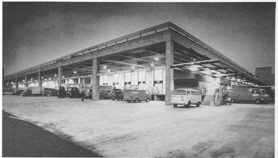
Bild 19. Der Importeuremarkt von Nordwesten. Die Verladerampen sind wettergeschützt überdeckt
