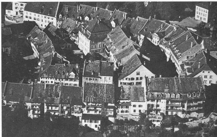
Bischofszell, Kanton Thurgau. Die aufgrund des Plans der Grubenmann nach dem Stadtbrand von 1743 wieder aufgebaute Markt-, Kirch- und Tuchgasse; im Gassenrücksprung freigestellt das Rathaus. Die Patrizier- und Leinwandherrenhäuser sind hauptsächlich um den Zeitglockenturm (rechts) geschart
