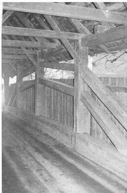
Bild 5. Innenansicht der Achmüli-Brücke über die Goldach
