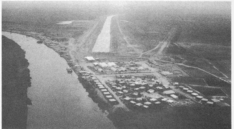
Luftaufnahme des Basislagers Sorbat. Im Hintergrund der Kanal. Das Lager ist aus Containern zusammengestellt, die als Altstoff gekauft, für eine letzte Fracht benützt und am Bestimmungsort zu Lagerzwecken zusammengesetzt wurden. In Gruppen vereinigt dienen sie als Büro, Wohnungen, Schule, Spital usw.
