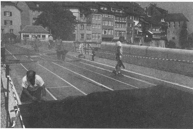
Bild 11. Aufbringen des Gussasphalts auf die Abdichtung
