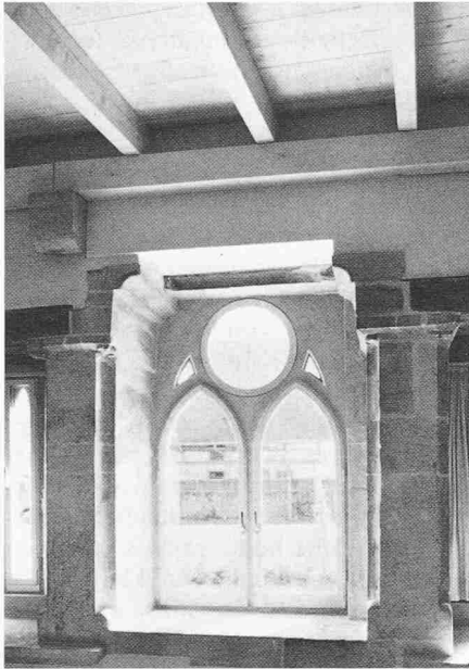
Direktorenwohnung Refektorium; alt: gotisches Mittelfenster, Pfeiler und Wandkonsole; neu: Fensterflügel aus Profileisen, Holzbalkendecke auf Streifbalken
