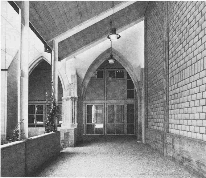
Kreuzgang NW-Ecke; alt: gotische Arkaden mit Eckpfeiler; neu: westliche Kreuzgang-Rückwand aus Profileisen mit Glas- und Holzfüllungen, nördlicher Kreuzgangflügel
