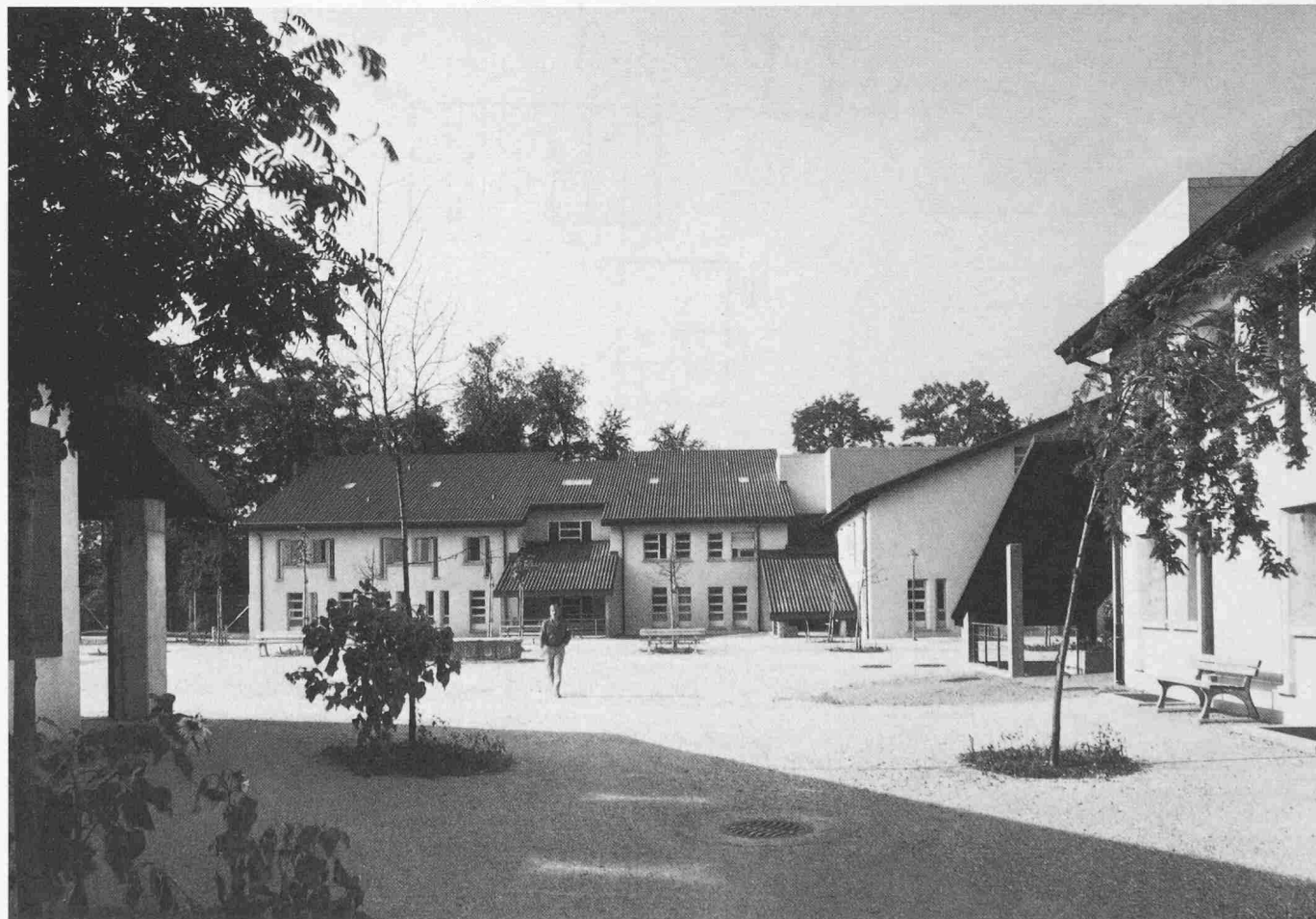
Insassenplatz mit Blick zum Insassentrakt C, links die Energiezentrale, rechts der Insassentrakt B
