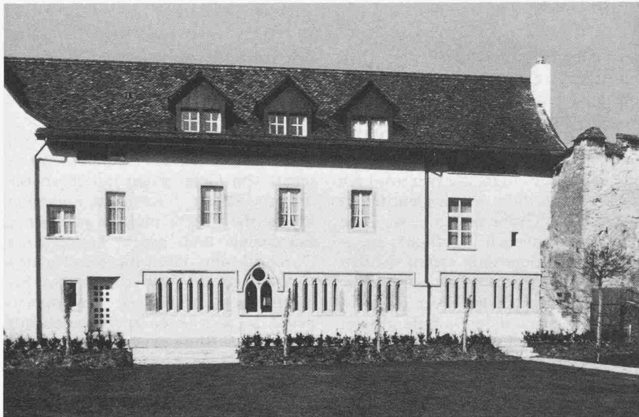
Das Klostergebäude vor und nach der Restauration
