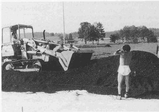
Bild 3. Verteilen und Planieren der zementstabilisierten Kehrichtschlacke auf der Baustelle. Die Verarbeitung kann auch mit einem Fertiger erfolgen
