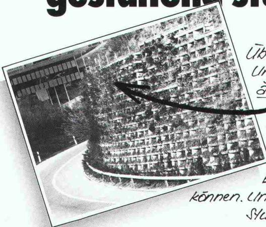
Überall, wo ein steiler Abhang Unterstützung braucht und erst noch ästhetisch aussehen soll, ist Murflex® mehr als am Platz. Die optimal begrünbare Raumgitter-Konstruktion, mit welcher – flexibel – entsprechend den örtlichen Gegebenheiten auch Nischen, Abtreppungen und Ecken ausgebildet werden können. Und – die in Notfällen innert Stunden ab Lager lieferbar ist.
