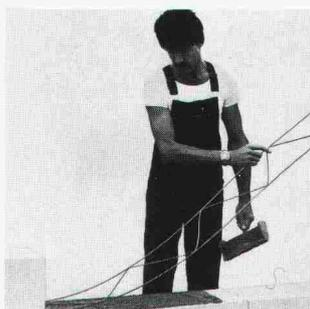
2 Armiert mit der SIPOREX-Stahlarmierung MURFOR, seit vielen Jahren bewährt, erhält das Mauerwerk eine hohe Gebrauchssicherheit. MURFOR wird aus Stahl III hergestellt, ist feuerverzinkt und kaltgewalzt. MURFOR wird in jede zweite Lagerfuge eingelegt.
