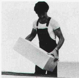
1 Gemauert als monolithisches, homogenes Fassadenmauerwerk mit dem k-Wert 0,24 W/m<sup>2</sup>K bei 35 cm Wandstärke, Qualität GL und 5 Gew.-% = Feuchtigkeit.
