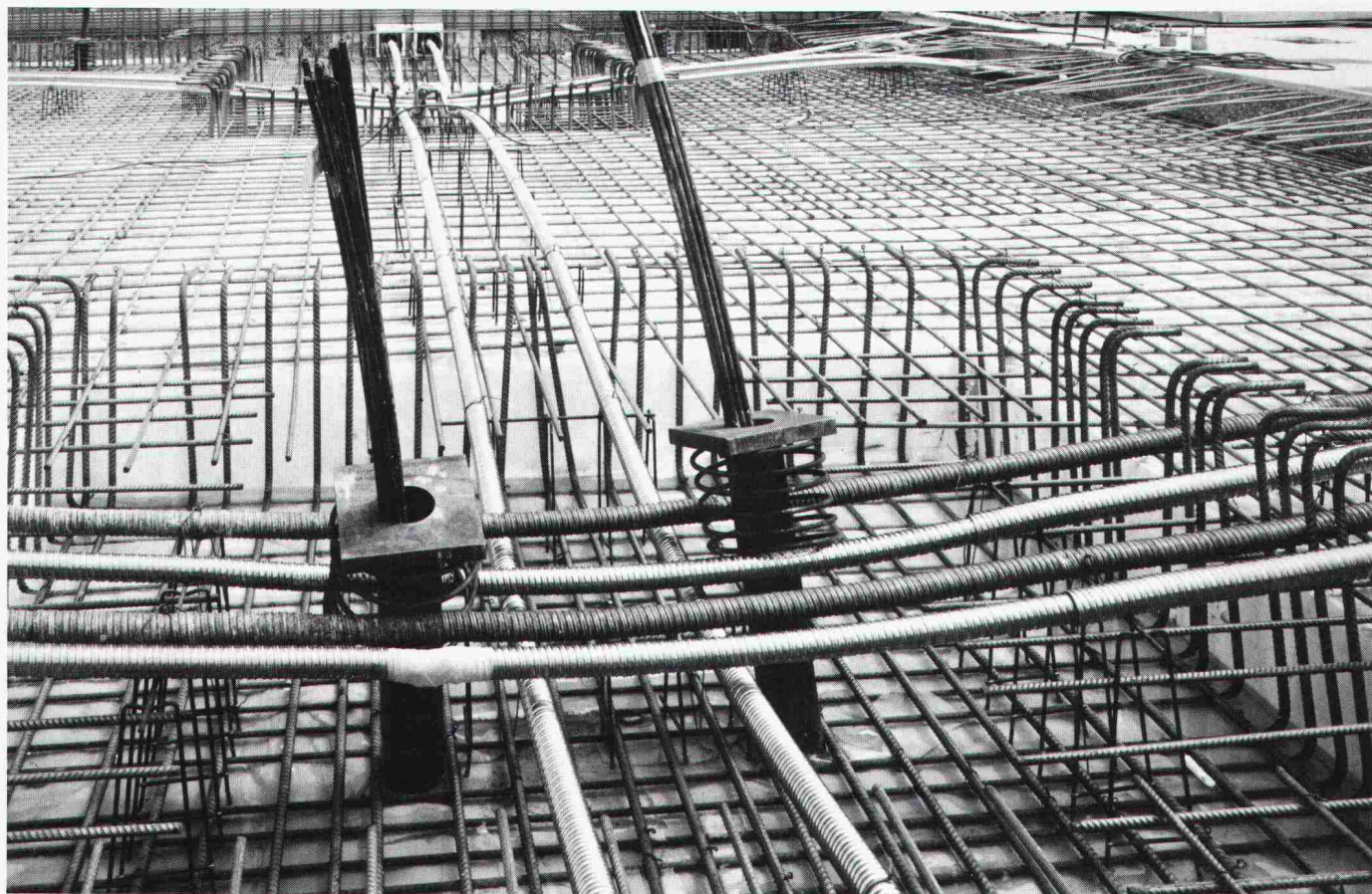
Parkhaus Sportanlage Kreuzbleiche, St. Gallen. Die Fundamentplatte liegt unter dem Grundwasserspiegel. Sie ist kreuzweise mit BBRV-Spannkabeln vorgespannt und zur Kompensation des Auftriebes mit CONA-Sol Gründungsankern niedergespannt.
