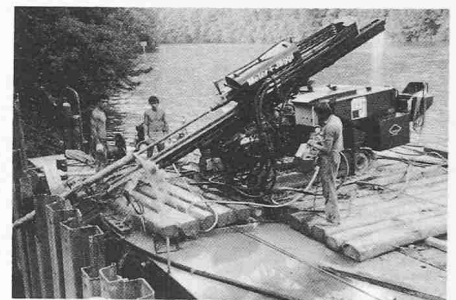
Bild 9. Bohrarbeiten für die Anker ab schwimmender Plattform
