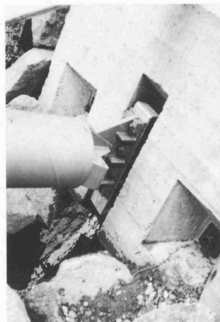
Bild 5. Schrägstützenfundament mit Stütze-gelenk. Links und rechts davon die Ankerköpfe der fertig versetzten Anker
