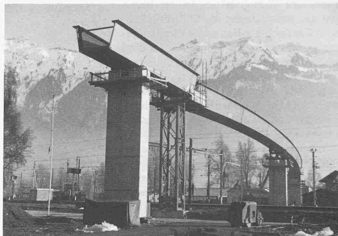
Viadukt Goldswil, Interlaken. Baujahr 1982
