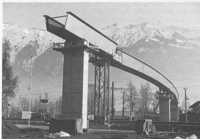
Viadukt Goldswil, Interlaken. Baujahr 1982
