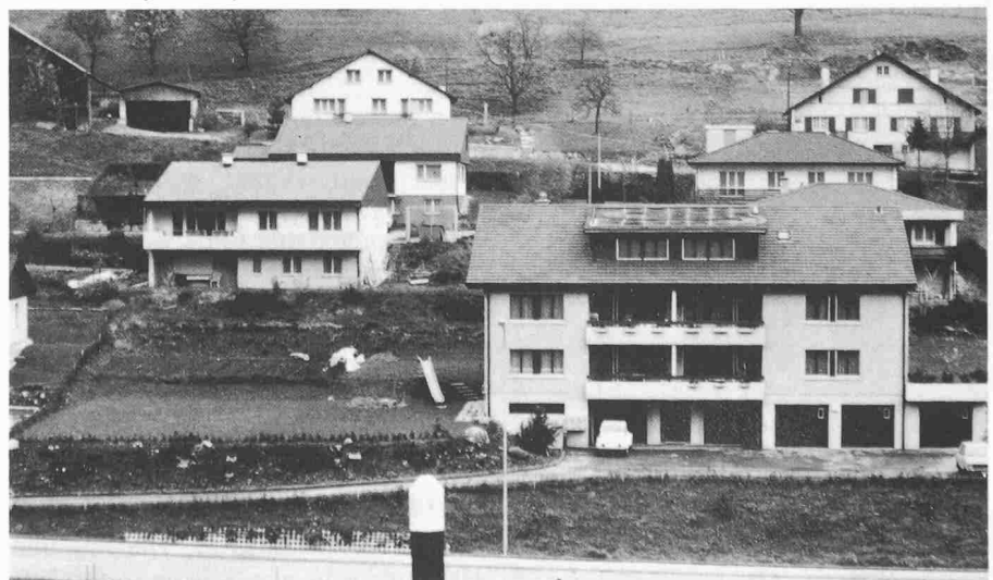
Bild 2. Messobjekt Mehrfamilienhaus, Ansicht von Süden. Links Kollektorbereich, rechts Referenzbereich
