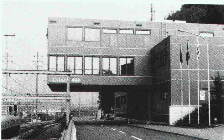
Neues Stellwerk Bahnhof SBB, Olten, Fahrbahnisolierung
