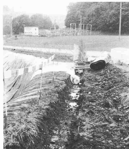
Bild 4. Das Geotextil Bidim wie auch die KDB Sarnafil P werden zusammen in einem auf der Böschungskrone ausgehobenen Graben eingelegt und verankert. Der Graben wird anschliessend zugefüllt (Foto: Sarna Kunststoff)
